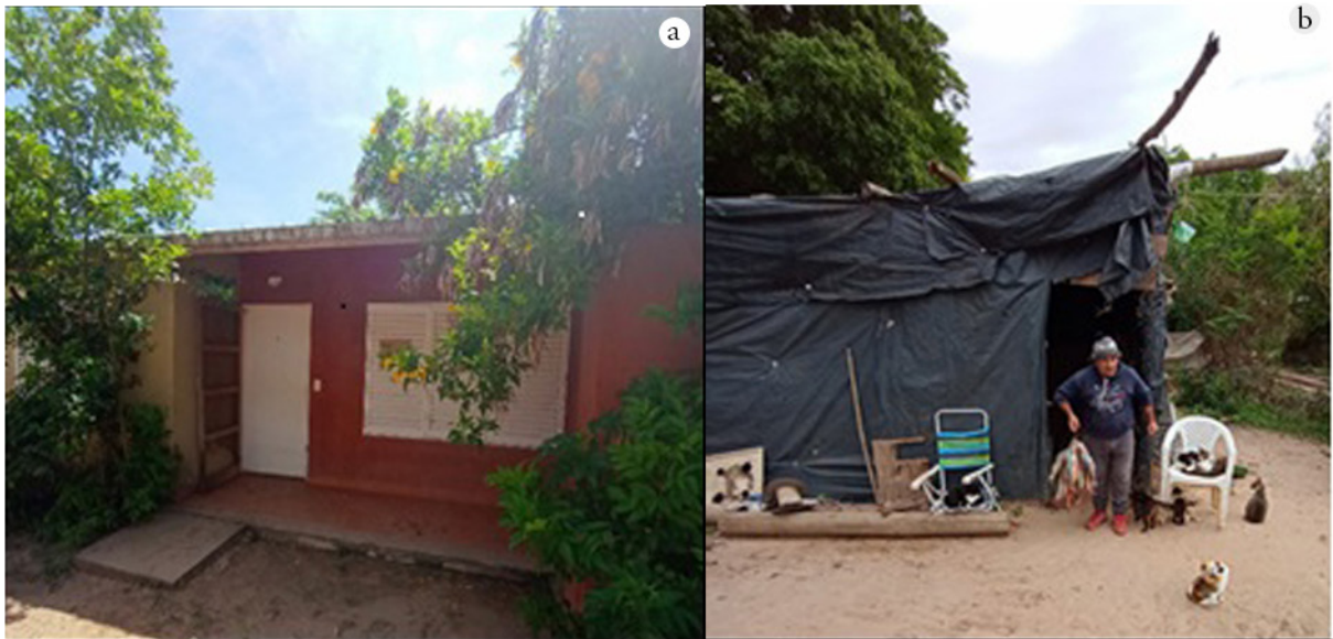
Figura 3. Tipologías de casas según el INDEC (2010), en la ribera del río Paraná, en la margen perteneciente a la Provincia del Chaco, Argentina. a) Ejemplo de casa tipo A; b) ejemplo de casa tipo B.
