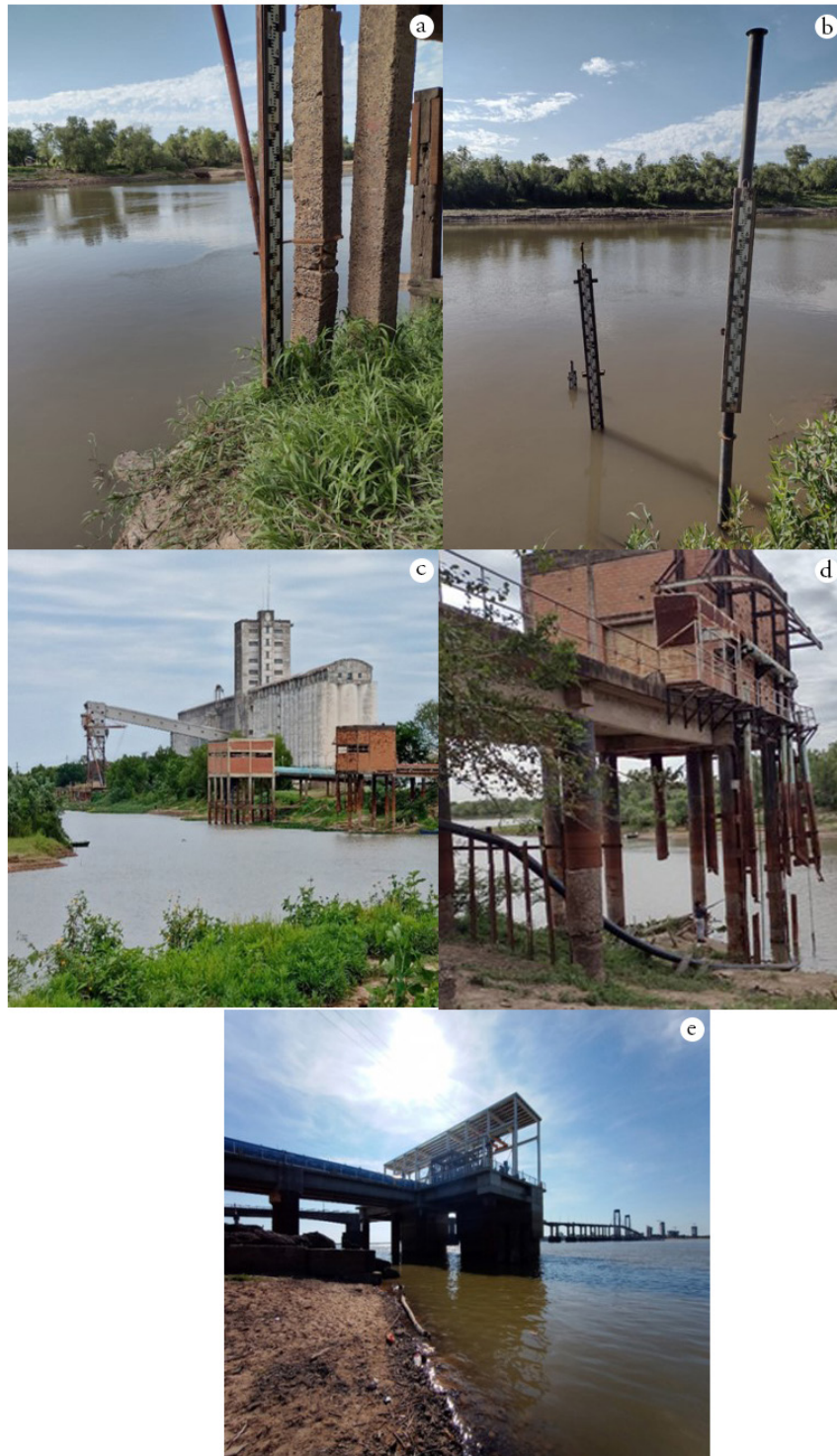
Figura 2. Hidrómetros y tomas de agua en Riacho Barranqueras, Provincia del Chaco, Argentina.
